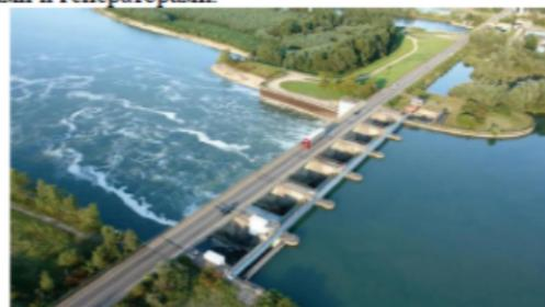
Во время приливов водохранилище станции (или устье реки) наполняется водой. Водяные потоки проходят через узкие ниши плотины и создают высокое давление. Под давлением столба воды лопасти гидротурбины начинают вращаться и вращают соединённый с турбиной ротор генератора, который вырабатывает электрический ток. С началом отлива вода покидает бассейн и вновь проходит через плотину, приводя в движение лопасти турбин.
